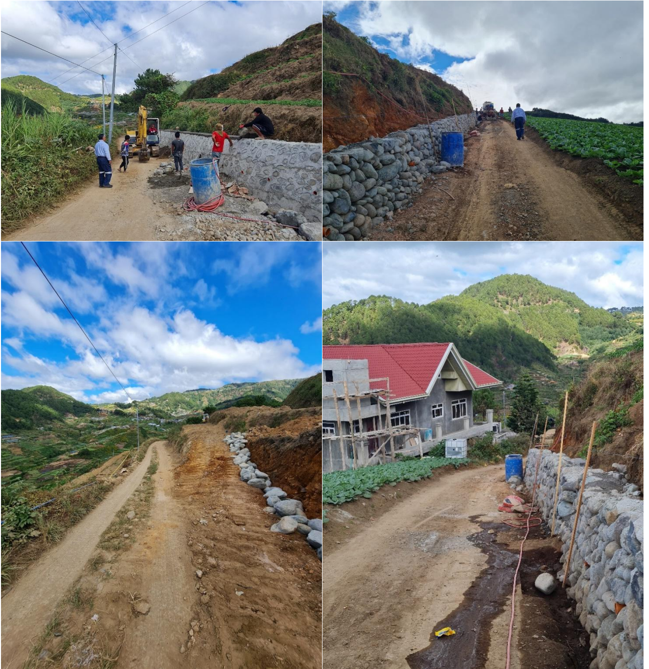
Photo2. Sitio Colocol Culvert Project.
